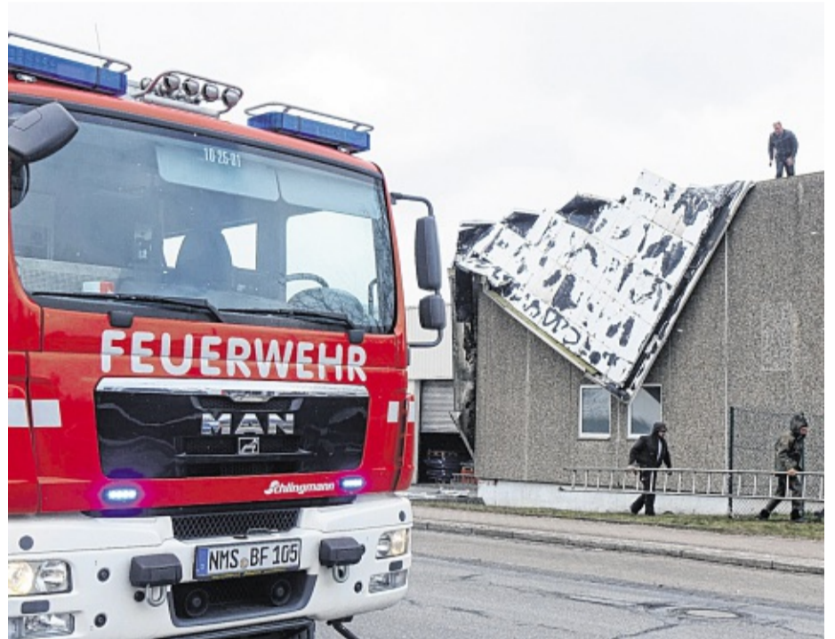
Ein großer Teil des Daches auf einer Lagerhalle an der Gadelander Straße drohte herabzufallen. Feuerwehr und Polizei sicherten die Einsatzstelle bis ein Dachdecker eintraf. JKG
